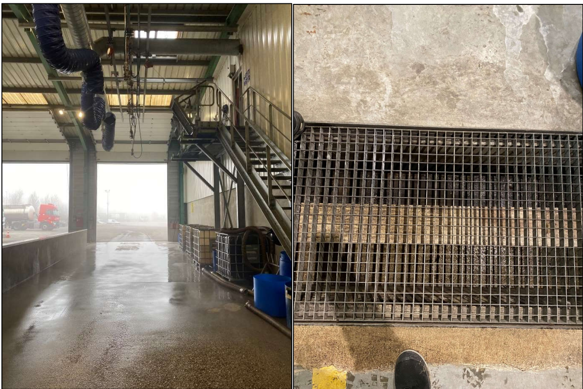
Figure 47. Photographies de la piste de lavage chimique (à gauche) et de sa rétention (à droite)
